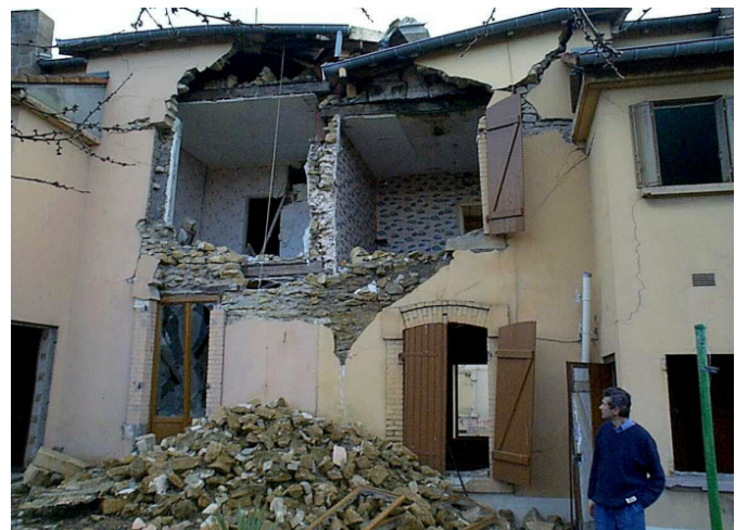
Conséquence sur le bâti des affaissements d'Auboué (bassin ferrifère lorrain)
